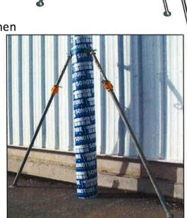
Dieses SONAPLON-System ist nur für eine senkrechte Positionierung geeignet und kann nicht für geneigte Anwendungen eingesetzt werden.
