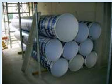
Les bastaings et les étais sont à proscrire car ils déforment les coffrages au niveau de l'appui et entraînent une courbure du coffrage ou des marques.
