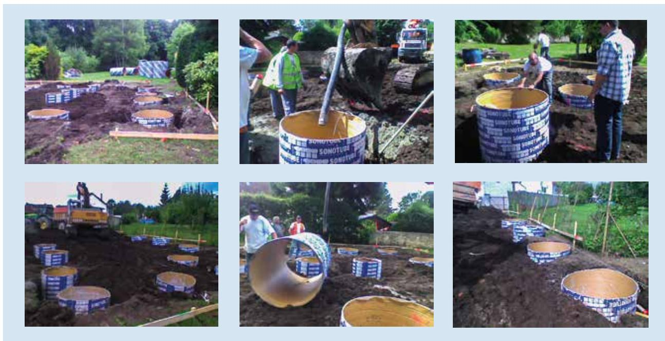
Quand le sol de bonne qualité se trouve à une très grande profondeur, il faut chercher à transmettre les charges des fondations au-dessus de ce sol. Les fondations profondes serviront d'intermédiaire pour la transmission des charges jusqu'au bon sol.
